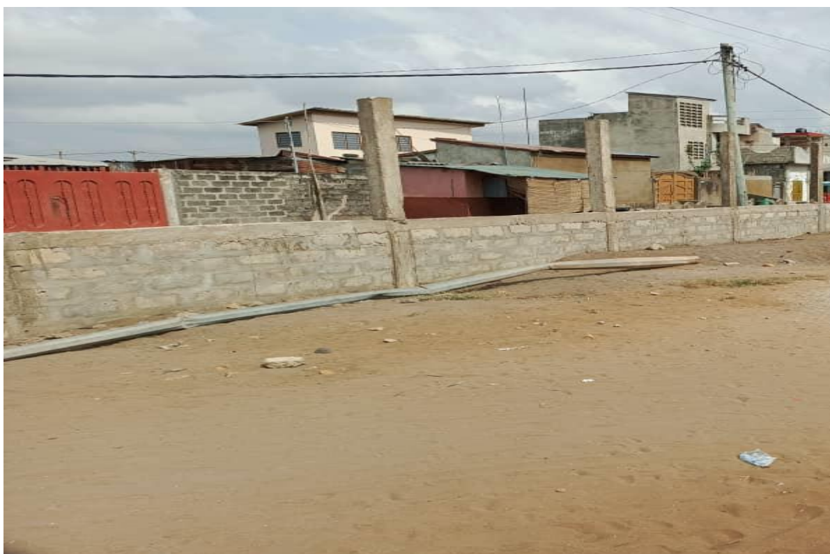
I4- Photos de réalisation d'une clôture du site de GBODJETIN constituée d'un mur de soubassement et des poteaux isolés en élévation
