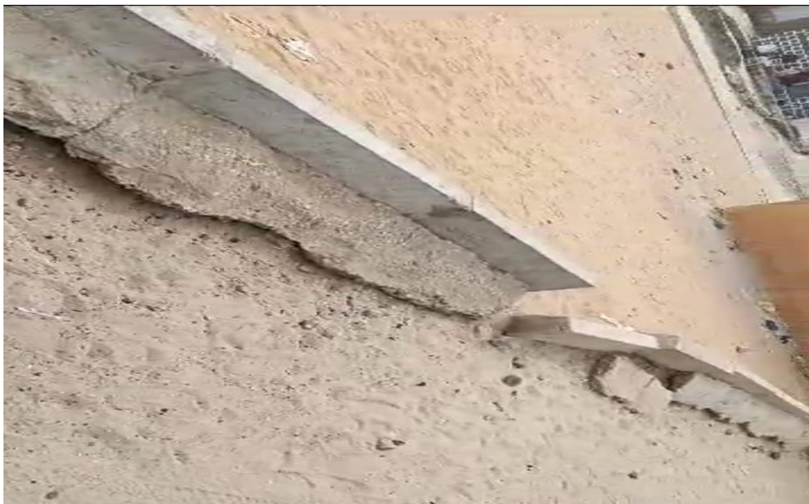
I 5 - Quelques bordures déjà réalisées sur le site de l'ESPACE VERT dit "Le désert" à FIFADJI se sont déposées et d'autres sont menacées de suivre du fait d'un affouillement progressif du sol sous les bordures, entraînant une perte de soutien structurel
