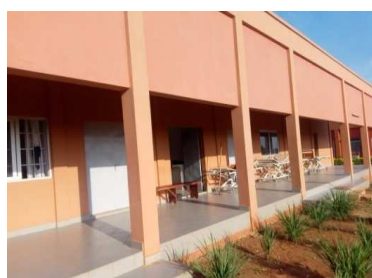
Unité de maintenance
