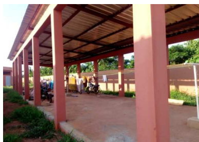
Hangar de séchage
