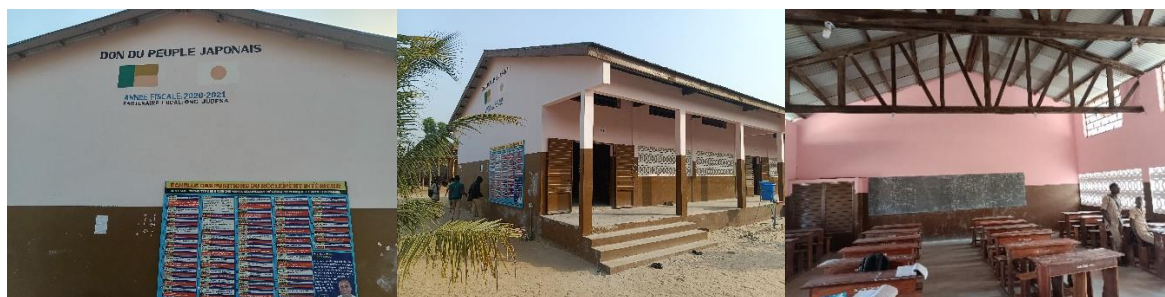
Photo 65 : Montrant la construction et l'équipement d'un module de quatre (04) salles de classe au CEG Pahou
