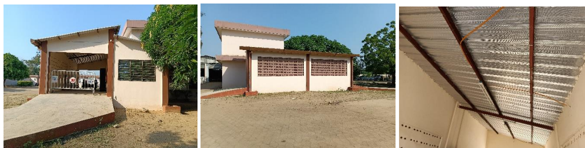
Photo 26 : Montrant les travaux de construction d'un hall à la Direction de la CNSR
