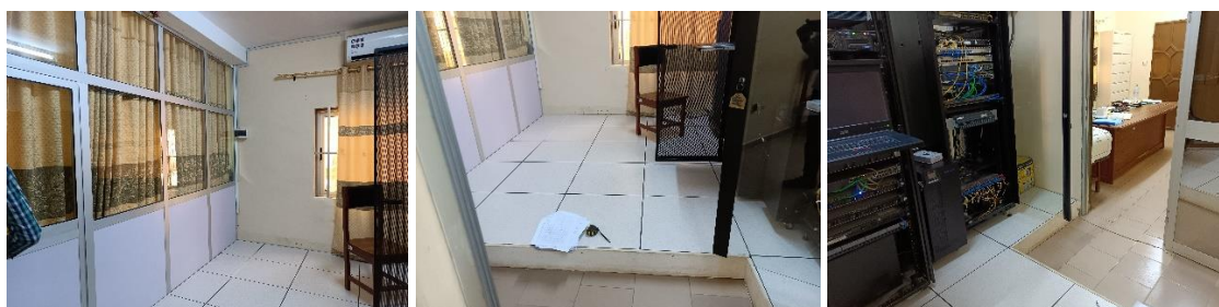
Photo 47 : Montrant les travaux d'aménagement de la salle SERVER
