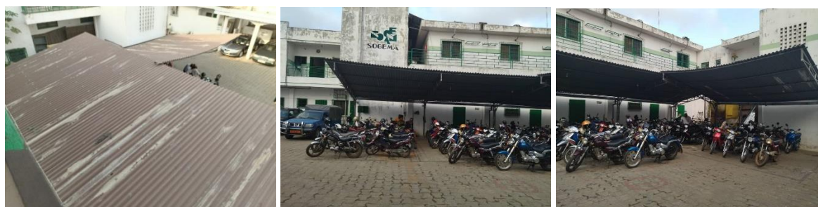
Photo 80 : Montrant les travaux de construction du parking de la SOGEMA
