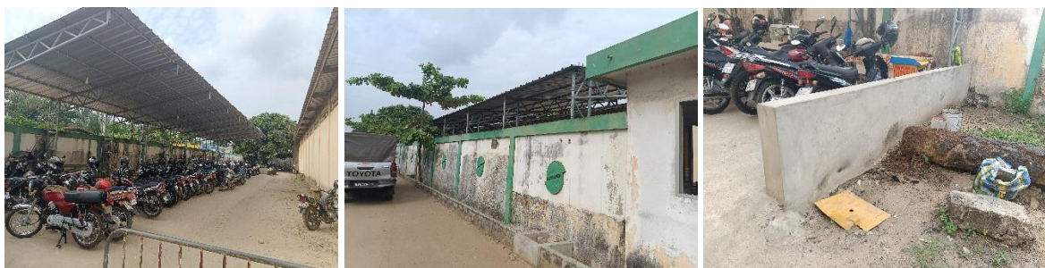
Photo 13 : Montrant l'état de l'ouvrage : Construction d'un parking pour dix véhicules pour le FNDA.
