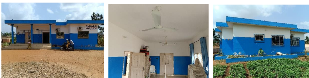
Photo 94 : Montrant les travaux de réfection des bureaux de l'Arrondissement d'Akpro-Missérété.
