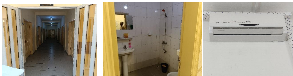
Photo 153: Montrant les Travaux de réfection et rénovation des unités de soins et des chambres d'hospitalisation (Lot 1).
