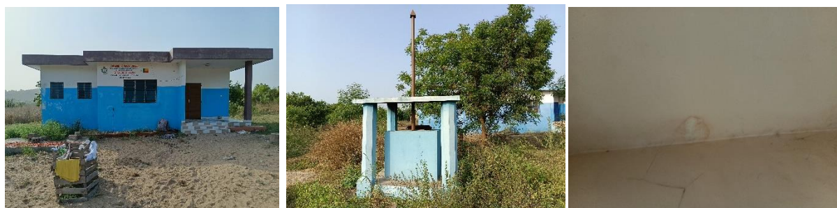
Photo 4 : Montrant des travaux et ouvrages concernés par le contrat de construction de logement infirmier et d'incinérateur.
