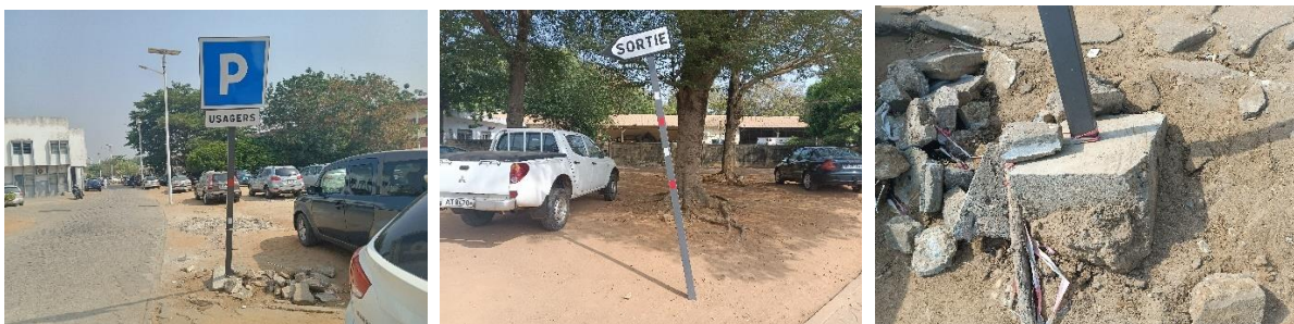
Photo 179: Montrant les travaux de signalisation verticale et horizontale
