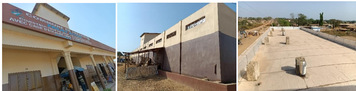
Photo 44 : montrant les Travaux de construction d'un bloc de 9 boutiques en RDC avec cage d'escalier dans le marché TCHAKITIBAM dans le 2 e arrondissement de Parakou.
