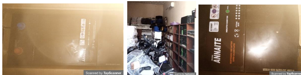
Photo 118 : Montrant les équipements acquérir.
