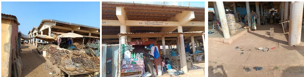
Photo 43 : montrant la Construction de trois (03) hangars de type H2 au marché Rose Croix Banikanni de Parakou
