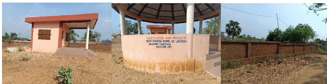
Photo 61 : Montrant des travaux d'aménagement de la place publique de Akodédjro
