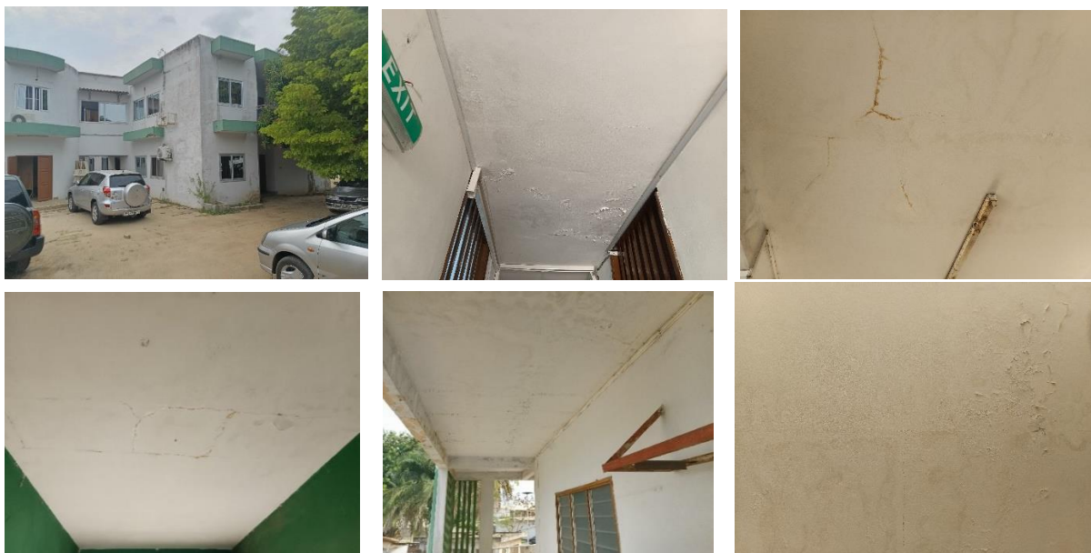
Photo 12 : Montrant les travaux d'étanchéité de la dalle.
