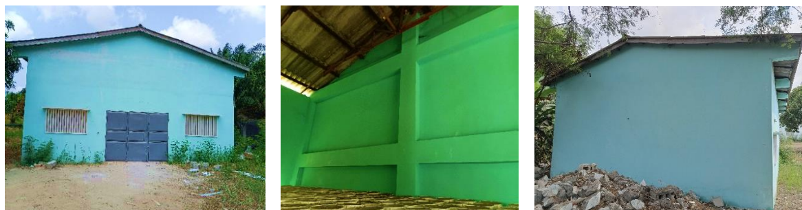
Photo 20 : Montrant la reprise d'un pan du mur de l'usine d'eau de Vêdoko et de l'aménagement du bâtiment de la station d'eau de Dogbo-Ahomey
