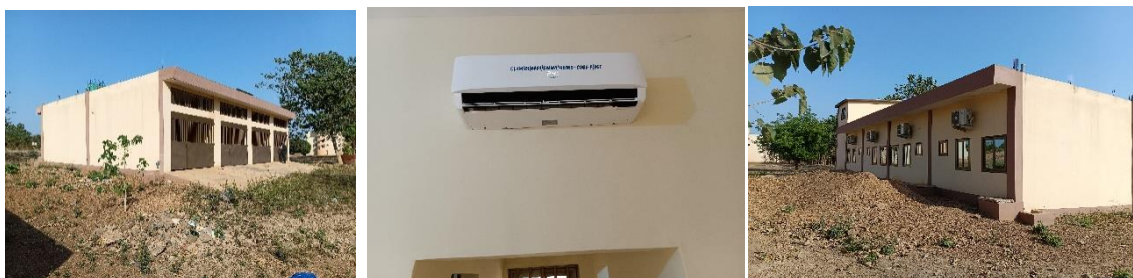
Photo 176: Montrant l'état de l'ouvrage : Construction de studios dans la cité universitaire du campus de Parakou.
