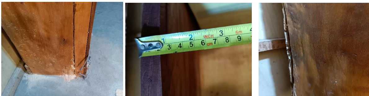
Photo 11 : Montrant les placards de rangement.
