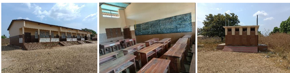
Photo 172: Montrant les travaux de construction d'un (01) module de trois (03) salles de classe avec bureau magasin et équipements plus un bloc de latrine à (04) quatre cabines à l'EPP Amadou Kpara B (LOT 2).
