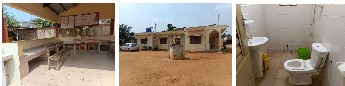
Photo 105 : Montrant les travaux de réception du dispensaire au centre de santé de MARIA-GLETA.
