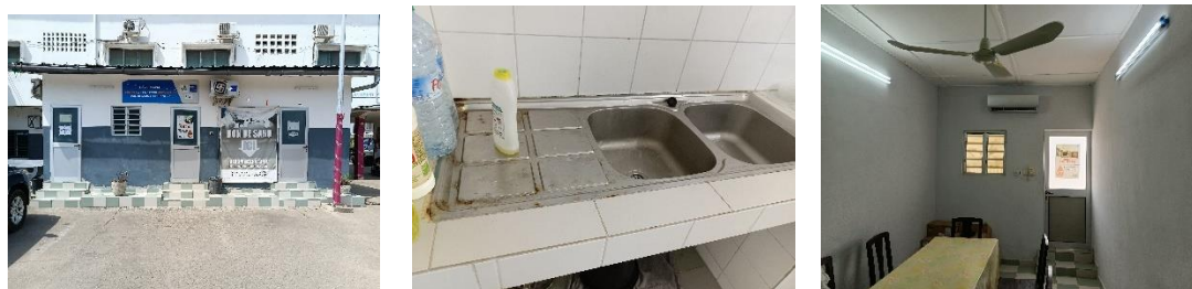
Photo 90 : Montrant La réhabilitation du bâtiment du laboratoire du CHU-MEL.
