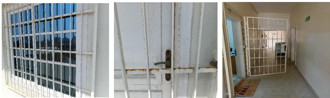
Photo 127 : Montrant la présence et l'état des grilles antieffraction et portes de sécurité
