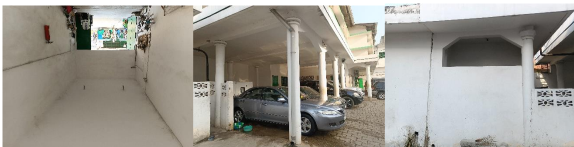
Photo 81: Montrant les travaux de badigeonnage de la Direction Générale de la SOGEMA
