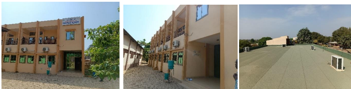
Photo 49 ; montrant les Travaux de construction de l'extension en R+1 du bloc administratif de la Faculté de Médecine (FM) de l'Université de Parakou (Relance).
