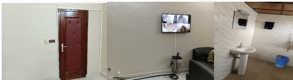
Photo 143: Montrant les travaux de réfection des bureaux du Secrétariat Administratif du Ministère de la Santé.
