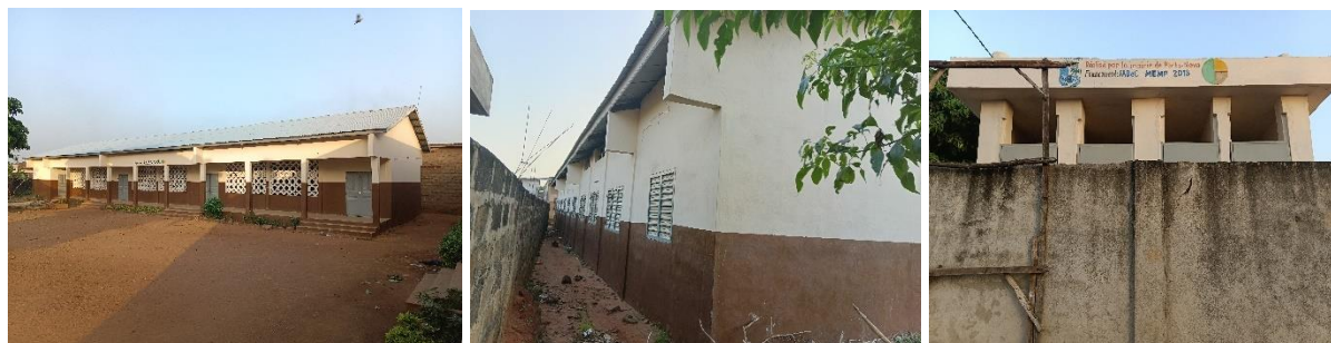
Photo 91 : montrant la Construction d'un module de 03 salles de classes plus bloc de latrine à 4 cabines dans cinq (05) EPP de la ville de Porto-Novo / Lot 3
