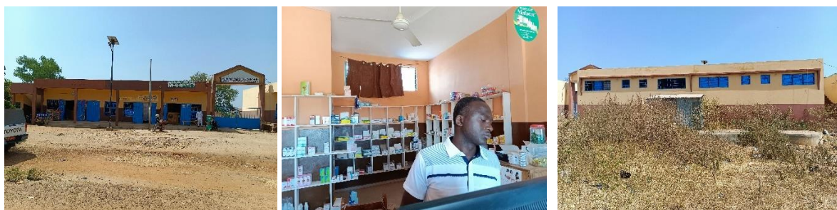
Photo 9 : Montrant l'état de l'ouvrage : Construction d'un bloc de quatre (04) boutiques à COPARGO.
