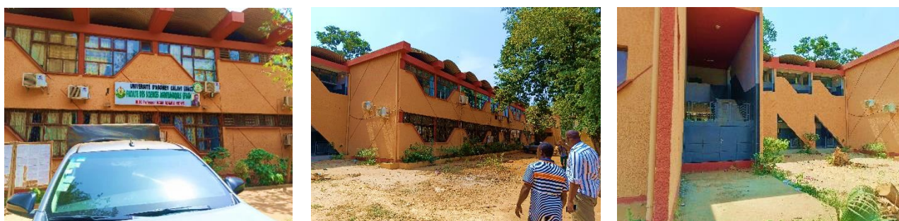
Photo 37 : montrant les Travaux de réfection des bâtiments administratifs et Amphis de la FSA
