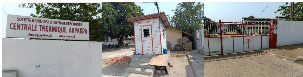
Photo 74 : Montrant les travaux de réalisation de portails et de divers aménagements à la centrale thermique d'AKPAKPA
