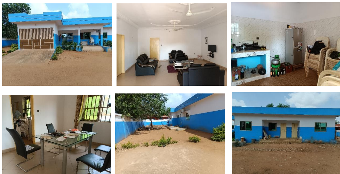
Photo 95 : Montrant les travaux de réfection de la résidence du Maire.
