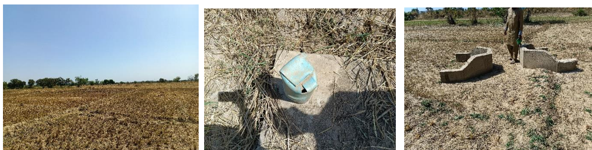
Photo 1 : Montrant l'état d'avancement des travaux d'aménagement de 80 ha pour la riziculture
