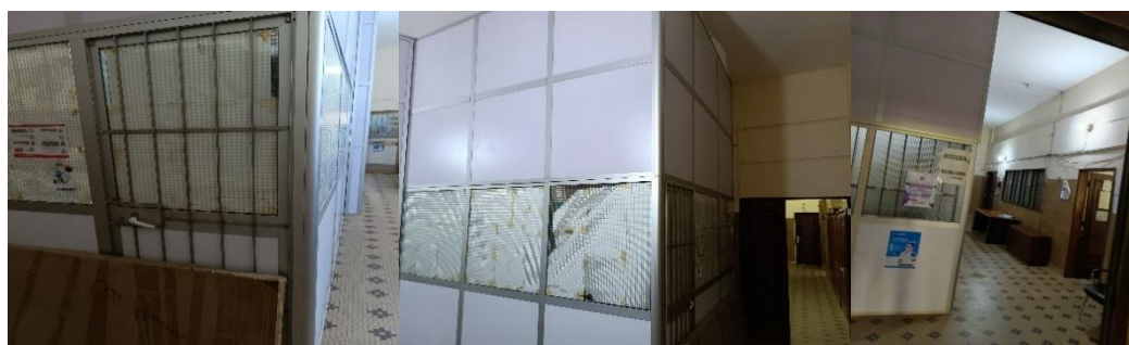
Photo 145 : Montrant les travaux cloisonnement d'une salle en quatre bureaux dans les locaux de l'Agence Béninoise de Régulation Pharmaceutique (ABRP).
