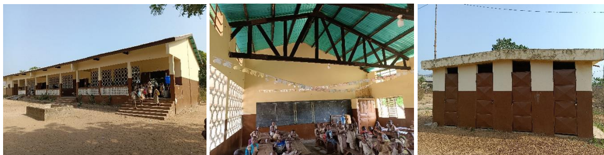
Photo 6 : Montrant le module de 3 salles de classes plus Bureau magasin et le bloc de latrine à quatre cabines.
