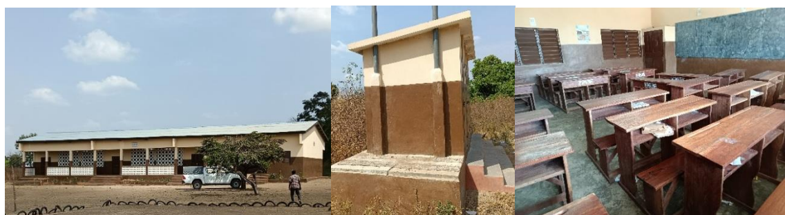
Photo 171 : Montrant les travaux de construction d'un module de trois (03) salles de classe avec bureau magasin et équipements plus un bloc de latrine à (04) quatre cabines à l'EPP Tchatchou centre D (LOT 3)
