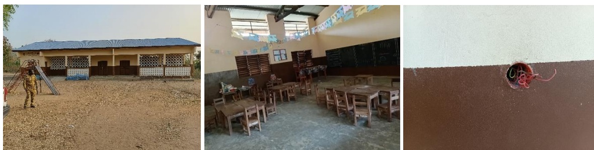
Photo 5 : Montrant l'état de l'ouvrage : construction d'un module de deux classes avec bureau et magasin et équipements mobiliers à l'EPP de Togon.
