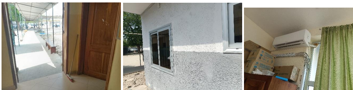
Photo 180 : Montrant les Travaux d'aménagement de huit (08) bureaux de différents services du plateau technique et mise aux normes d'une salle de bloc en CUGO Conformité des ouvrages par rapport aux normes techniques
