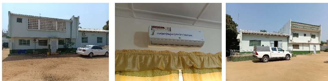
Photo 111 : Montrant les travaux de réfection de la cellule de la communale de Cotonou pour abriter le centre de quarantaine et de fumigation de la Direction de la Production Végétale.
