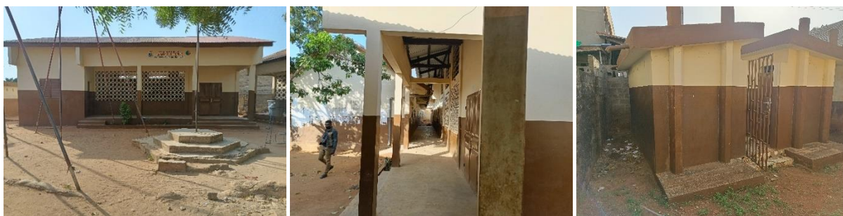
Photo 92 : montrant la Construction d'un module de 03 salles de classes plus bloc de latrines à 4 cabines dans cinq (05) EPP de la ville de Porto-Novo / Lot 4
