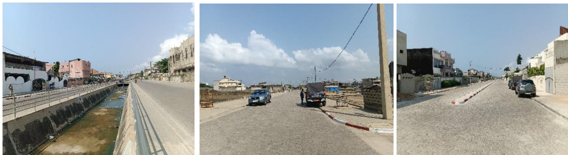
Photo 141: Montrant l'état de l'ouvrage : la voie général Brathier-clôture PARC MIVO dans la commune de Sèmè-Kpodji (pk 10).
