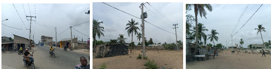
Photo 104 : Montrant les travaux de réseau dans les localités de TOGBIN 1 ET 2.
