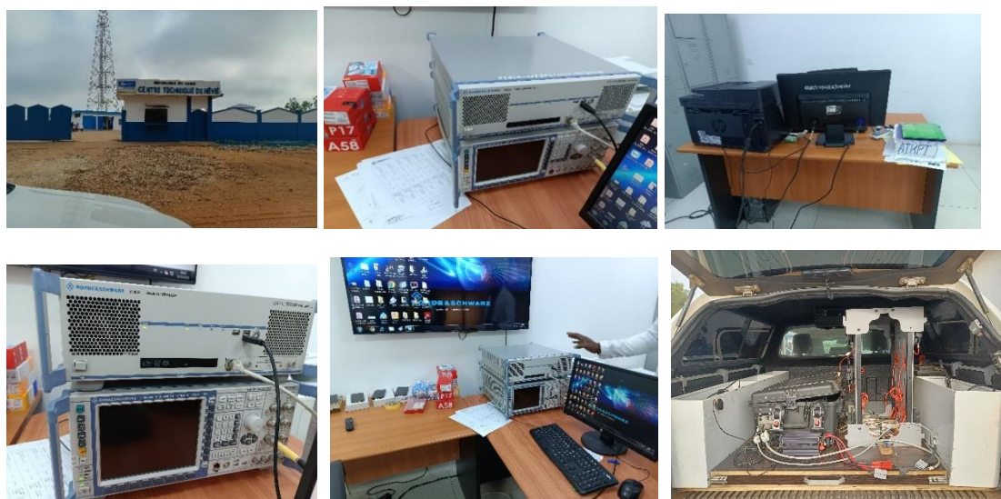
Photo 67 : Montrant les travaux de construction d'un laboratoire de test des équipements terminaux et radioélectriques au Centre Technique de HEVIE + maintenance
