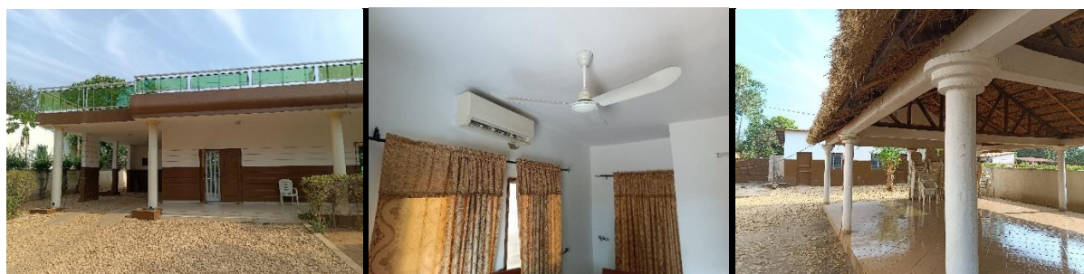
Photo 60 : Montrant les travaux de réfection de la résidence du maire de Lokossa
