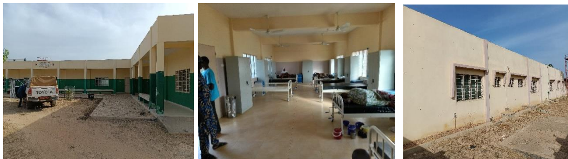
Photo 130 : Montrant le bâtiment polyvalent Rez-De-Chaussée (RDC) avec fondation de type R+1 plus équipements médico-techniques.
