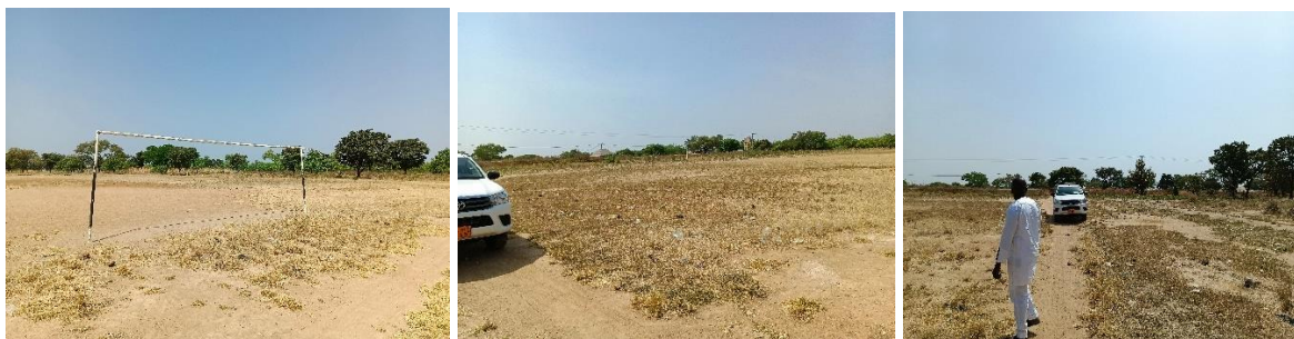
Photo 10 : Montrant le site d'installation des équipements et ouvrages.
