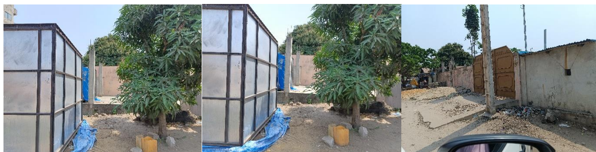
Photo 76 : Montrant les travaux d'aménagement et de réfection à Akpakpa et Porto-Novo ; Lot 1
