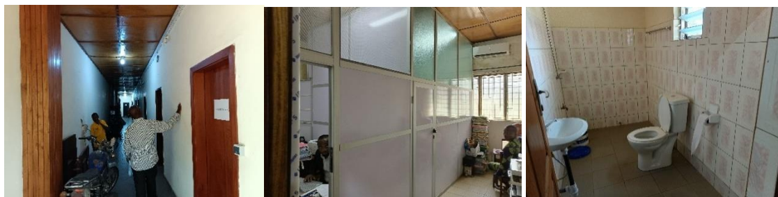
Photo 144 : Montrant les travaux de Réfection du bâtiment abritant le PNCEFFS.
