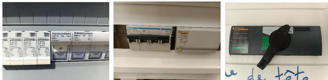
Photo 124 : Montrant les travaux des installations électriques et mise en place d'un système de protection contre les coups de foudre Indirects au profit de l'Agence Nationale de l'Aviation Civile.
