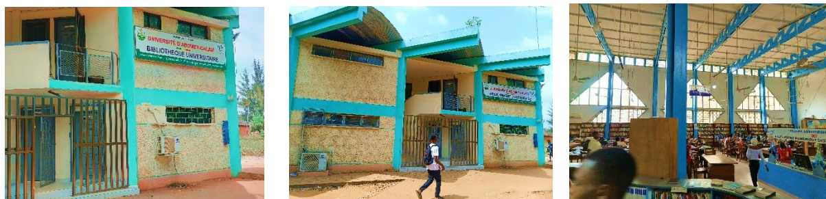
Photo 38 : Travaux de badigeonnage du bâtiment de la BU et carrelage des bureaux et de la grande salle de lecture au profit de la Bibliothèque Universitaire.
