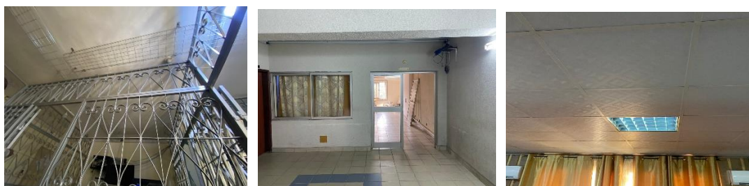
Photo 123 : Montrant les travaux au siège de la direction générale (lot1).
