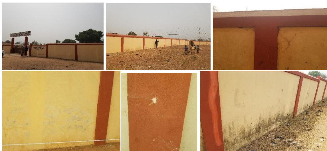
Photo 27 : Montrant les ouvrages et travaux de construction des clôtures.
