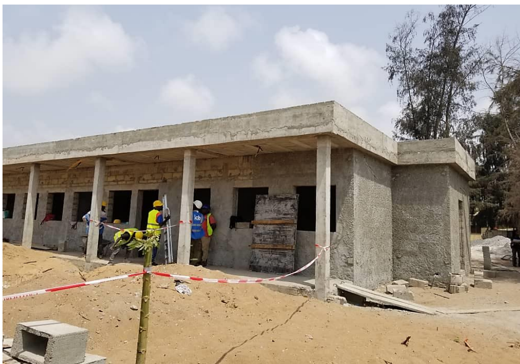
Photo 30 : Montrant l'aménagement de la zone Sud est de l'aéroport.
