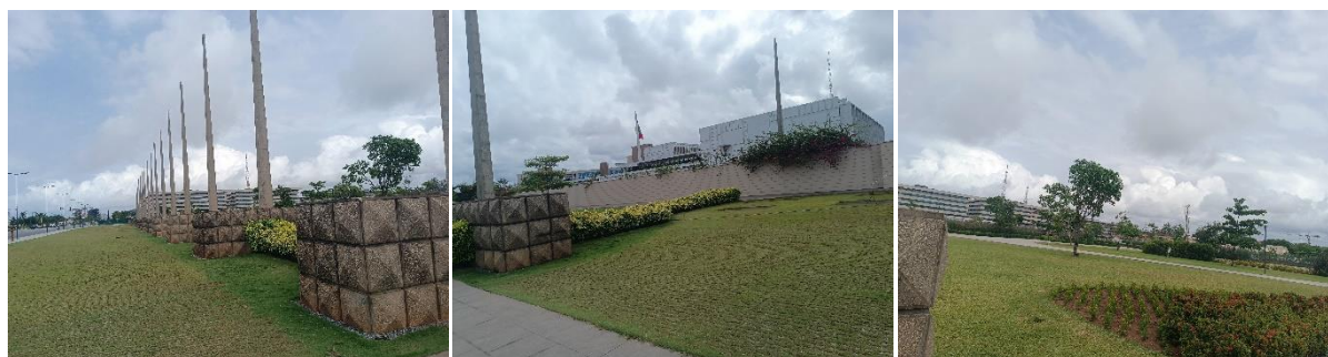
Photo 56_b : Montrant les ouvrages de Génie civiles réalisés à la place de l'indépendance
