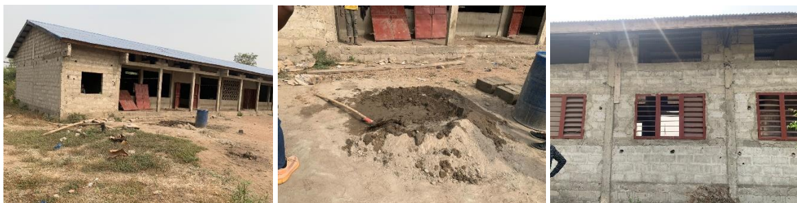
Photo 1: Montrant le niveau d'avancement des travaux de construction d'un module de 3 salles de classe avec bureau + magasin + bloc de latrine à 4 cabines
