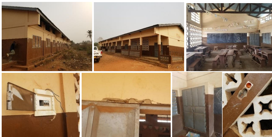
Photo 25 : Montrant des travaux et ouvrages concernés par le contrat de construction de cinq modules de trois classes dans trois écoles.
