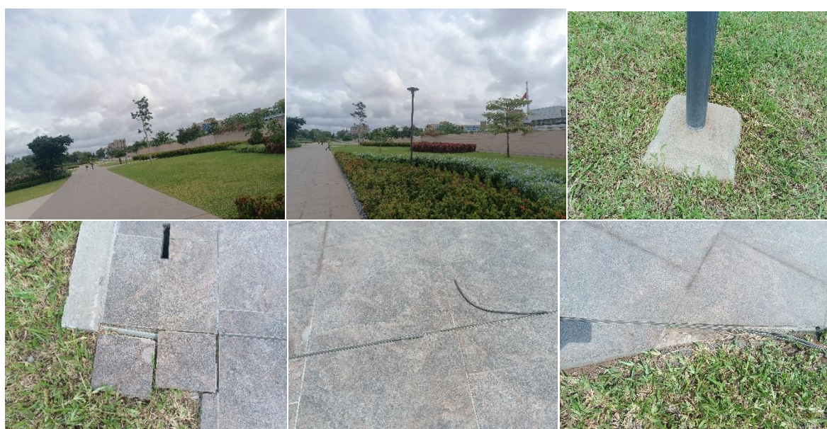
Photo 56_c : Montrant les ouvrages de Génie civiles réalisés au champ de foire sud
