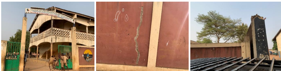
Photo 5: Montrant l'état de l'ouvrage : Construction de clôture de l'école urbaine centre de Djougou
