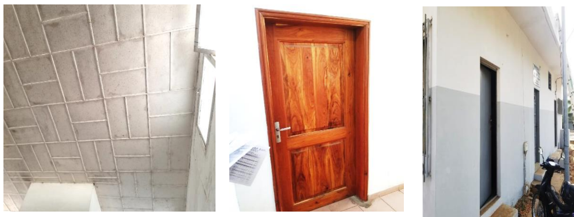
Photo 51 : Montrant la reprise des travaux de la couverture du bâtiment d'urologie, du dallage du local oxygène et d'aménagement du bureau du RESHAOC
