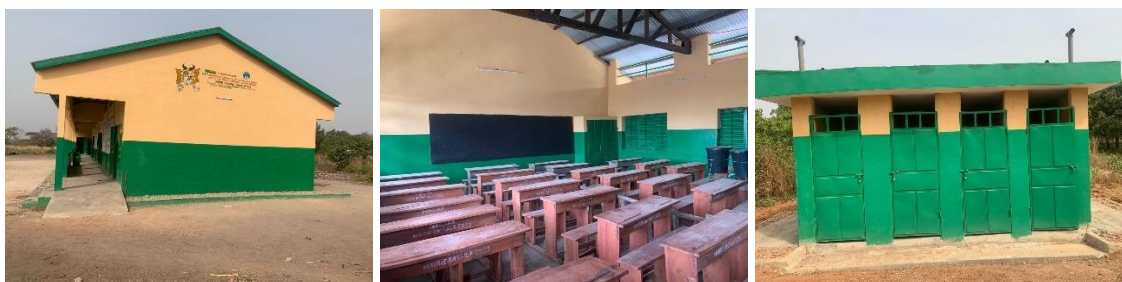
Photo 3 : Montrant l'état de l'ouvrage : Module de 3 salles de classe avec Bureau magasin + bloc de latrine.
