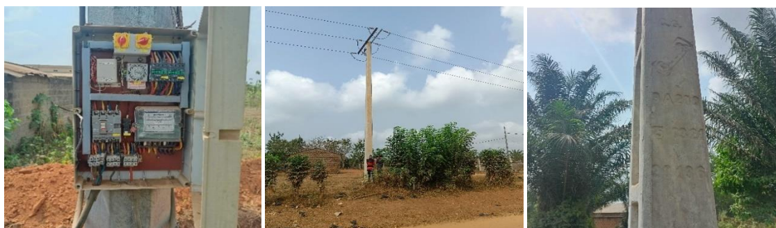
Photo 7 : Montrant les travaux de réhabilitation du réseau électrique de Tori-Cada
