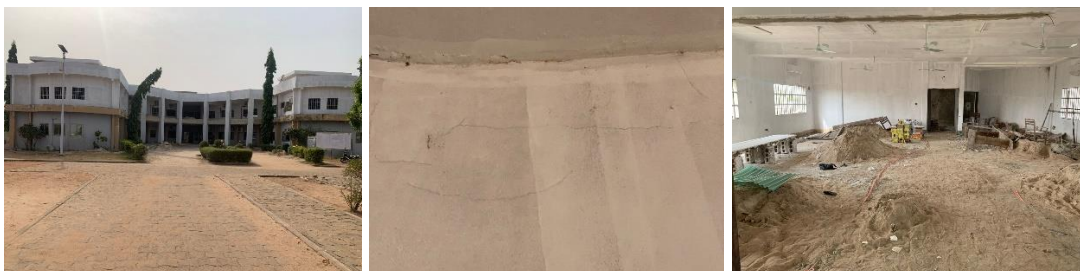
Photo 2 : Montrant les travaux d'extension de l'hôtel de ville de Bassila.
