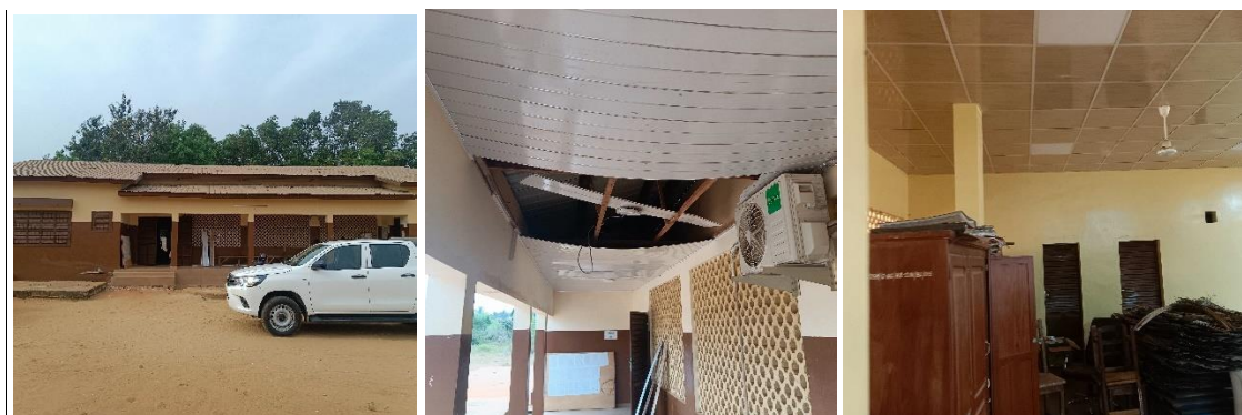
Photo 15 : Montrant de Réhabilitation de la maison des jeunes de l'arrondissement de Zinvié, commune d'Abomey-Calavi.
