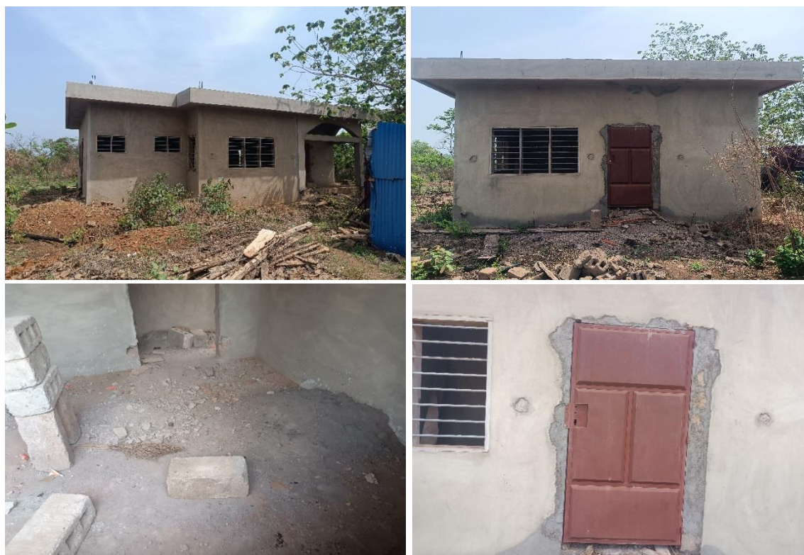
Photo 42 : Montrant l'état actuel des travaux de construction de logement infirmier.
