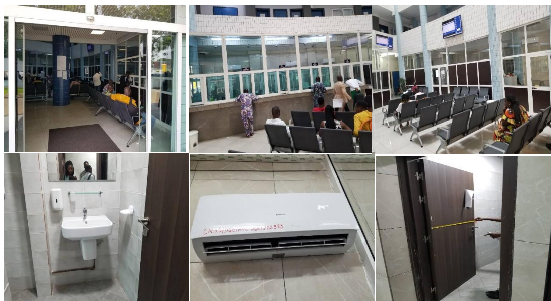
Photo 37. : Montrant le hall de la direction générale de la CNSS reconfigurée et aménagée
