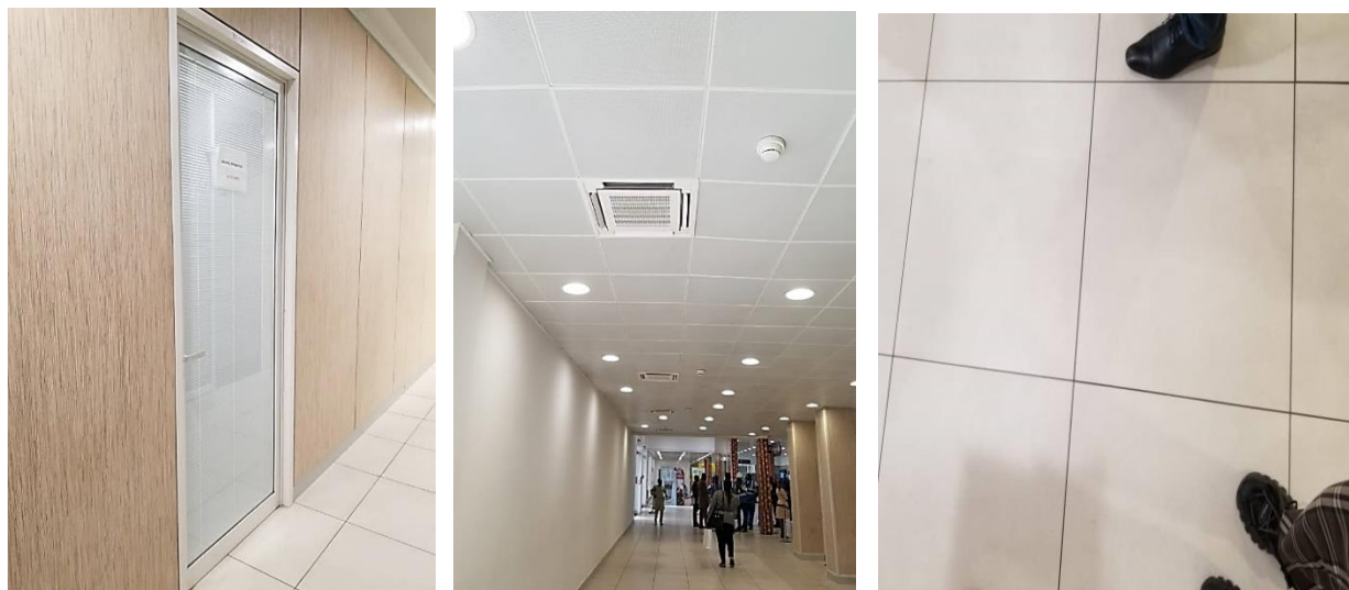
Photo 53 : Montrant ls travaux de réaménagement du Hall accueil de l'aéroport de Cotonou
