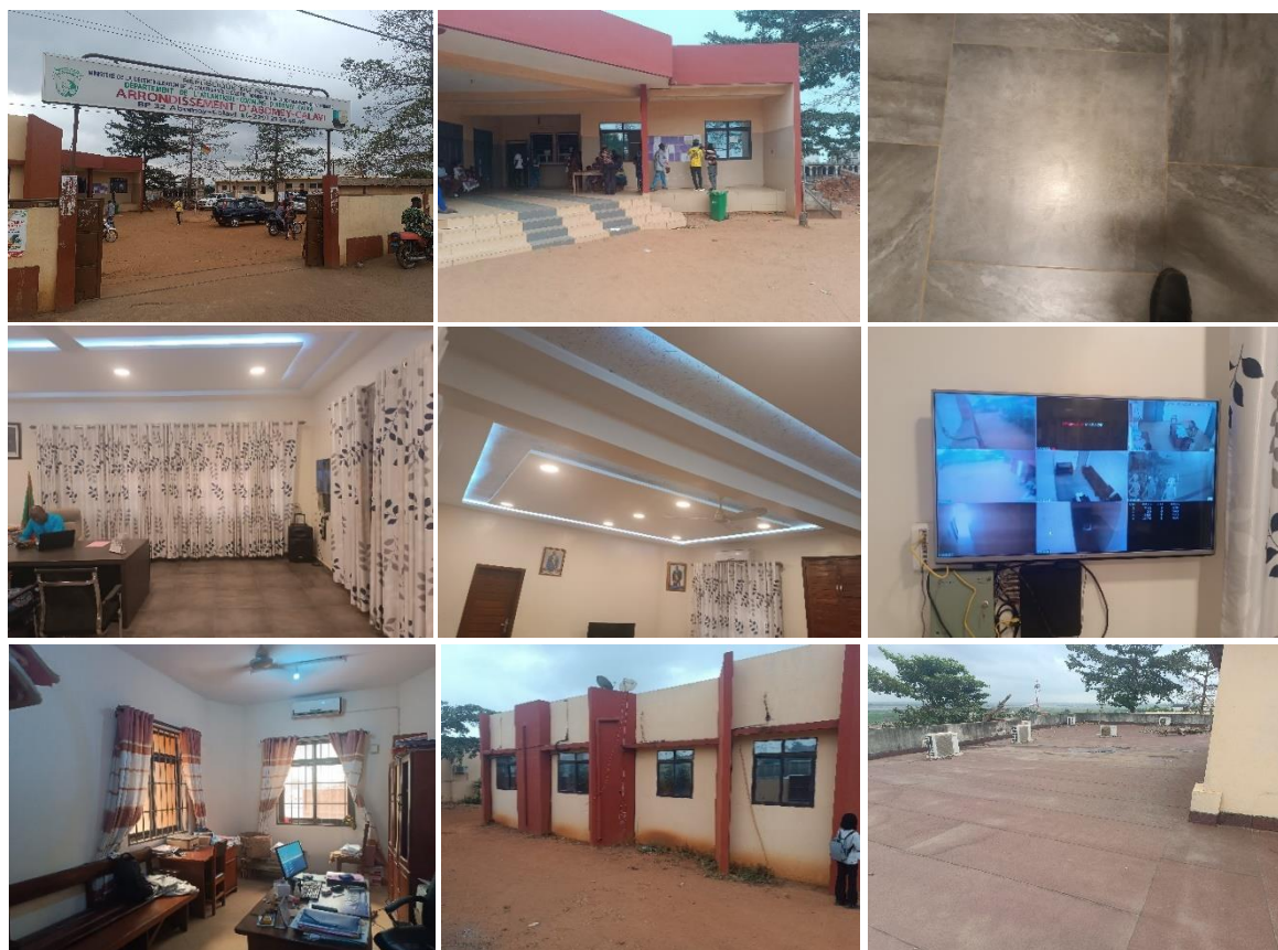
Photo 18: Montrant les ouvrages de la réfection de l'arrondissement de Calavi.
