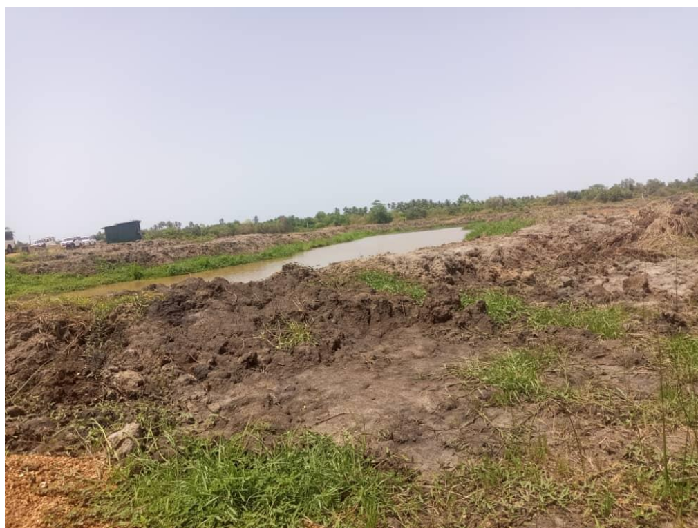
Photo 68: Vue du canal d'amenée du site de MATEKPO
