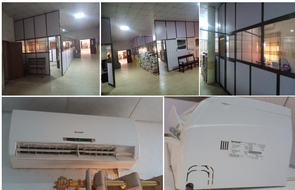
Photo 12 : Montrant les constructions Alu-Vitre et les climatiseurs
