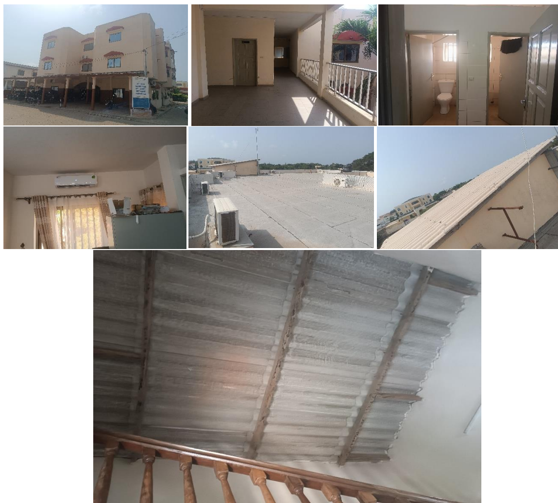
Photo 40 : Montrant les travaux de réfection du bâtiment R+2 au MS
