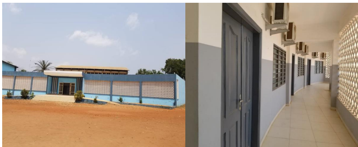
Photo 55 : Montrant construction du bâtiment de L'INE : Rez-de-chaussée des deux ailes.
