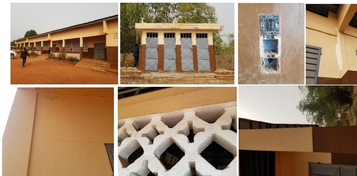
Photo 24 : Montrant des travaux et ouvrages concernés par le contrat de construction de trois modules de trois classes dans trois écoles.
