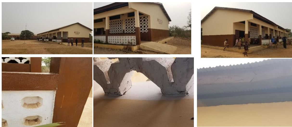
Photo 22 : Montrant des travaux et ouvrages concernés par le contrat de construction d'un module de trois classes simples.
