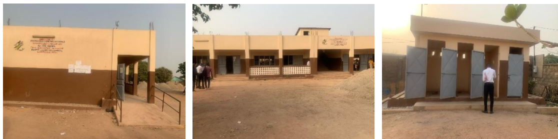
Photo 7 : montrant la Construction d'un module de quatre salles de classe dalle équipé de cent table bancs, quatre chaises et bureau d'enseignant et un bloc de latrines à quatre cabines au CEG GUEMA
