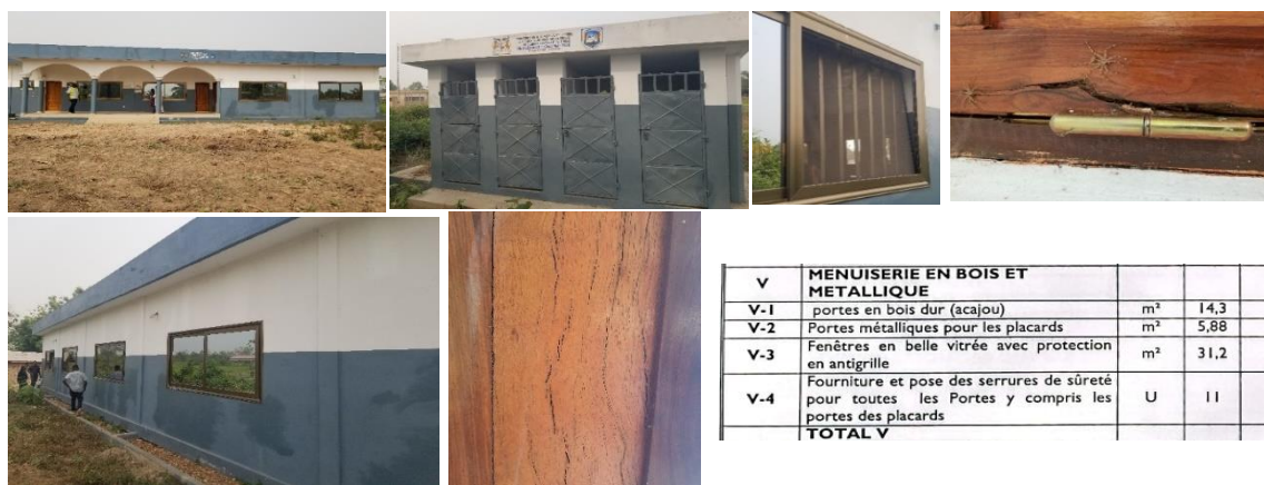
Photo 23 : Montrant des travaux et ouvrages concernés par le contrat de reconstruction de des bureaux de l'arrondissement de TOHOU
