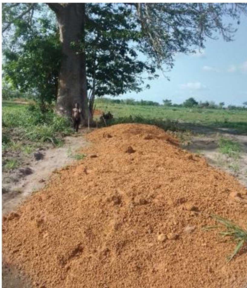
Photo 72: Canal d'irrigation en cours (sans compactage) sur le site de Linsadji
