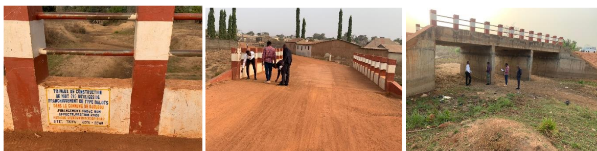
Photo 4 : Montrant l'ouvrage dalot 3*400*300 à Taifa kofa - Déwa.
