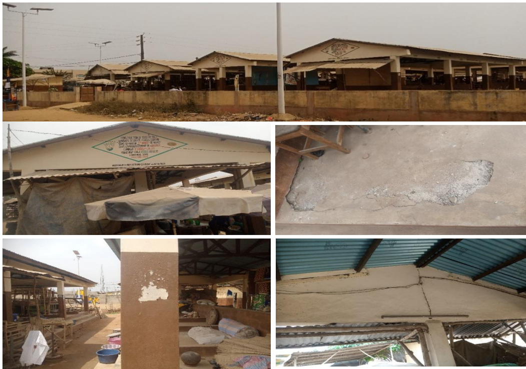
Photo 14 : Montrant les hangars construits dans le marché de Womey
