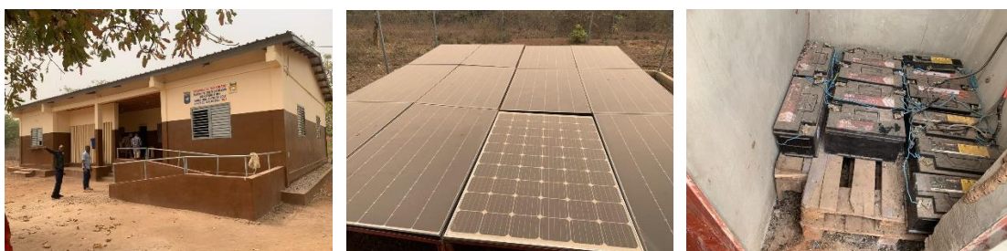
Photo 21 : Montrant la Construction d'une (01) maternité isolée plus un bloc de deux (02) latrines et deux (02) douches à Kpassa (Lot 1)
