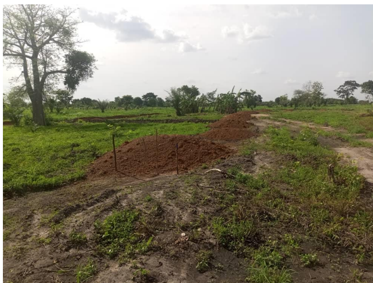
Photo 71: Apport latéritique sur le site de Linsadji
