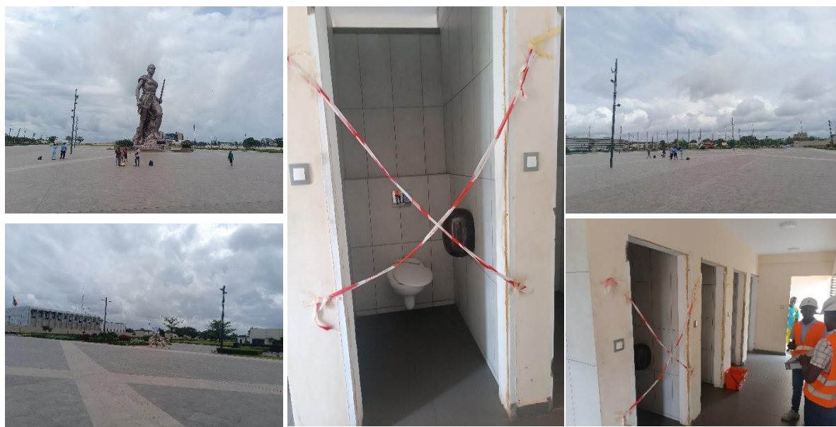
Photo 56_a : Montrant les ouvrages de Génie civiles réalisés sur l'esplanade de l'amazone
