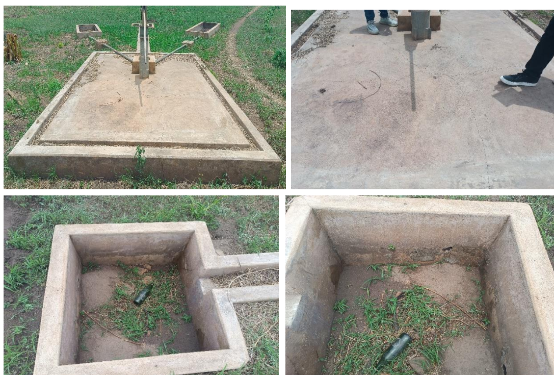
Photo 90_b : Montrant le forage et abreuvoir réalisé à ZA-KPOTA
