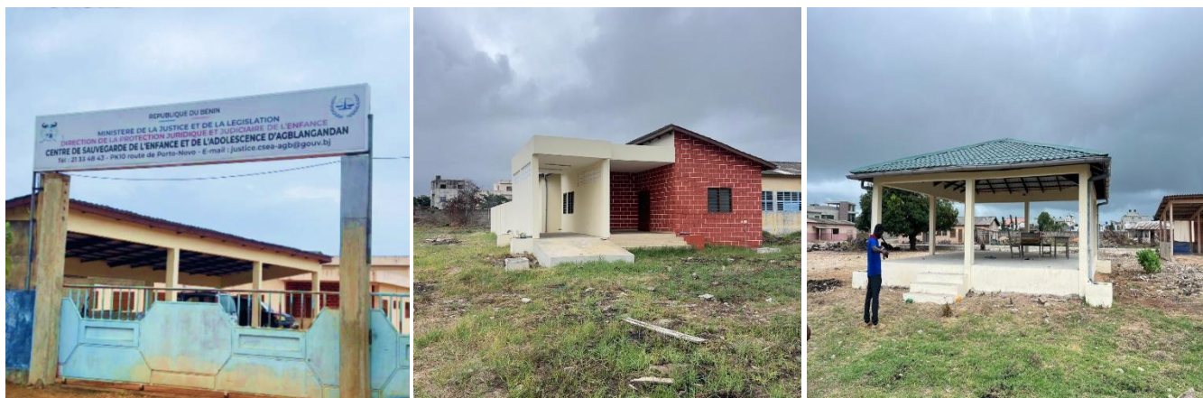
Photo 35 : montrant Travaux de réhabilitation du centre de sauvegarde de l'enfance et de l'adolescence d'Agblangandan
