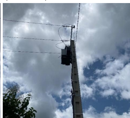
Photo 2 : Ligne électrique Moyenne Tension (MT) et Basse tension (BT) avec transformateur de 50 KVA et sélecteur aérien IACM pour moyenne tension (conforme)
