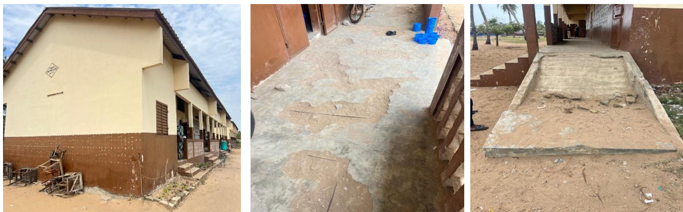
Photo 14. : Montrant le hall de la direction générale de la CNSS reconfigurée et aménagée 02 modules de 03 salles de classes + bureau + magasin + latrines + clôture à l'EPP OKOUN-SEME
