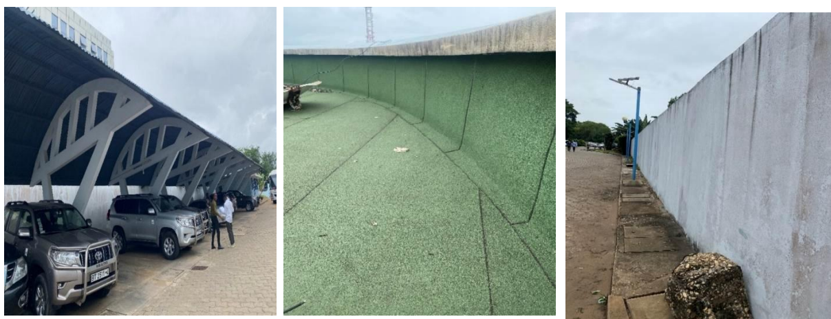
Photo 3 : Montrant les Travaux d'étanchéité, d'aménagement et de peinture du siège de la Direction Générale
