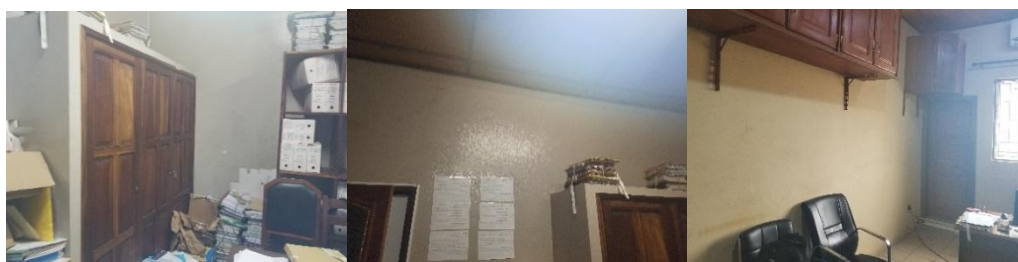
Photo 35 : Montrant travaux de réfection du bâtiment abritant les bureaux du PNCEFFS
