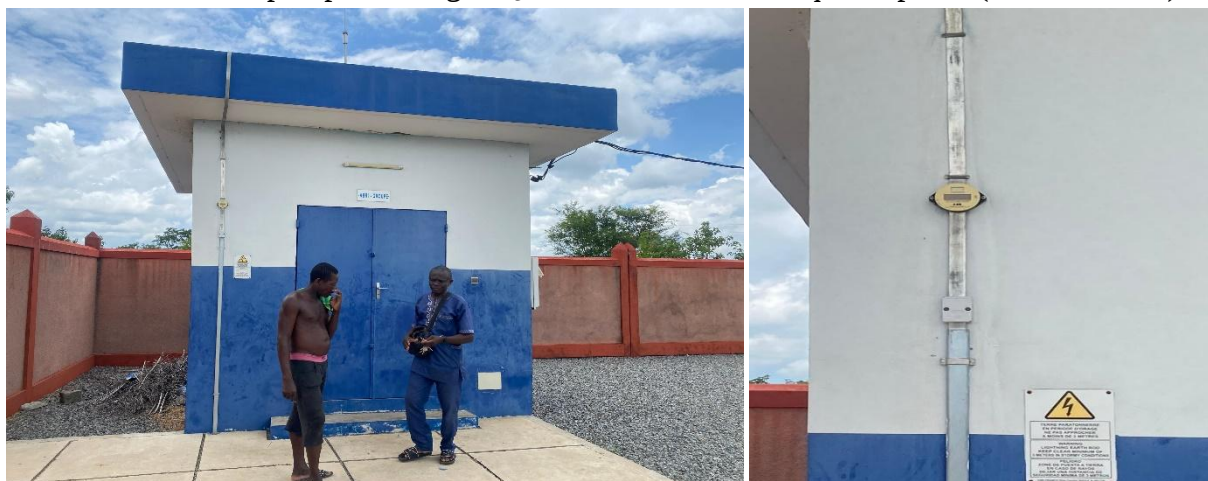
Photo 7 : Armoire de commande de puissance 3KW, de Hauteur Manométrique Totale HMT de 135m et de débit pompe immergée Q = 5m³ au lieu de 7m³ qui est prévu (non conforme)
