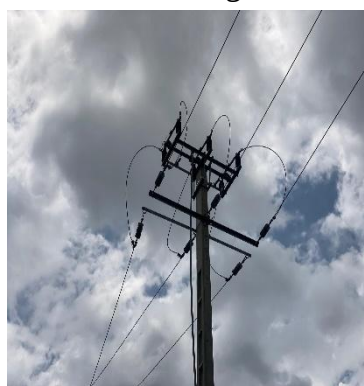
Photo 2 : Ligne électrique Moyenne Tension (MT) et Basse tension (BT) avec transformateur de 50 KVA et sélecteur aérien IACM pour moyenne tension (conforme)
