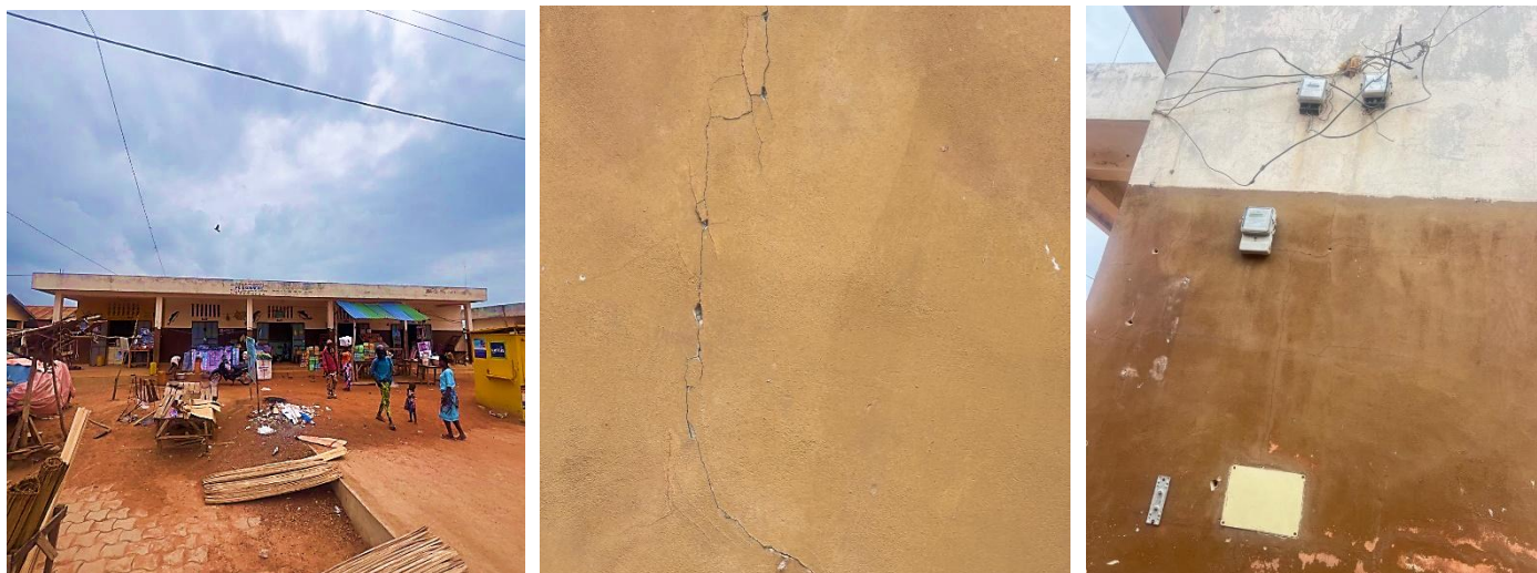
Photo 12 : Montrant la construction de deux blocs de cinq boutiques dans le marché de DJIDJA-CENTRE dans la commune de DJIDJA.
