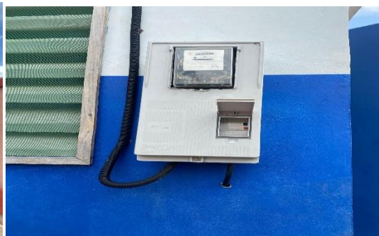
Photo 3 : Compteur SBEE de 30 A (conforme) Photo 4 : Bâtiment abri-groupe 3.40X3.40 et parafoudre (conforme)
