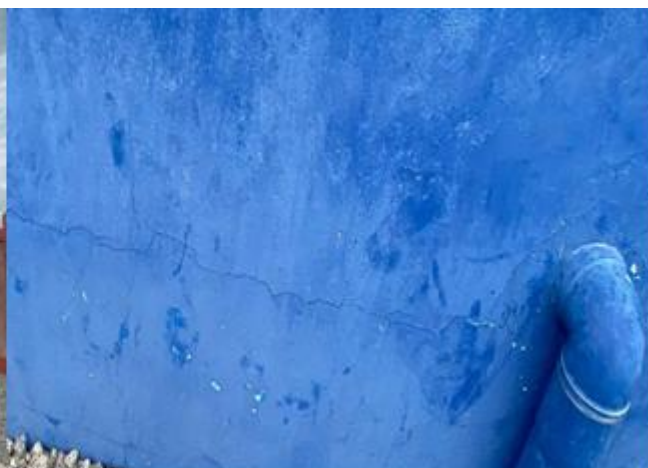
Photo 3 : Bâtiment forage 4.70X3.70 (conforme) Photo 4 : Fissure sur le bâtiment
