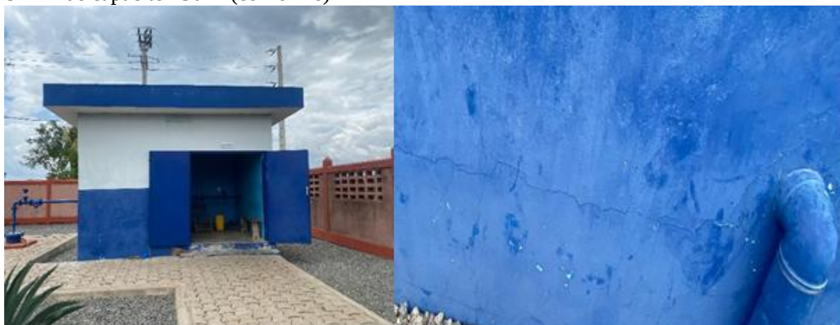
Photo 3 : Bâtiment forage 4.70X3.70 (conforme) Photo 4 : Fissure sur le bâtiment
