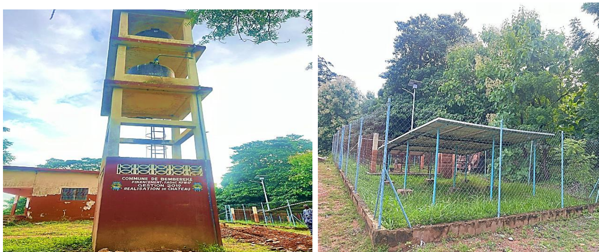
Photo 8: Montrant l'état de l'ouvrage château d'eau de 10m3 réalisé dans les locaux de la mairie de Bembéréké avec extension du réseau dans les locaux de l'arrondissement et de la salle d'archivage
