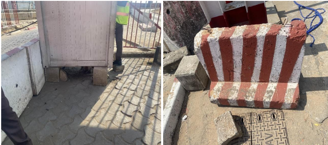
Photo 74 : Montrant les blocs de sécurité GBA amovibles et les socles pour cabines.
