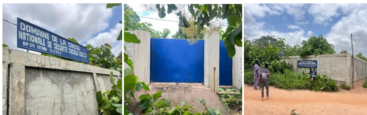
Photo 2 : Montrant Travaux de construction de la clôture du domaine de la CNSS sis à NIKKI Conformité des ouvrages par rapport aux normes techniques
