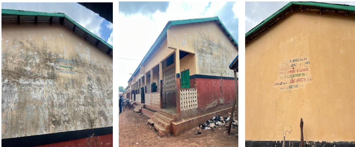
Photo 6: Montrant construction de quatre de modules des (02) deux classes avec bureau et équipements plus latrine pour les écoles primaires publiques de Sassiro et Yamoussa Gah dans la commune de Djougou
