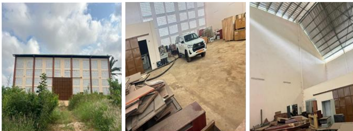
Photo : montrant construction d'un magasin sur le site d'abomey-calavi
