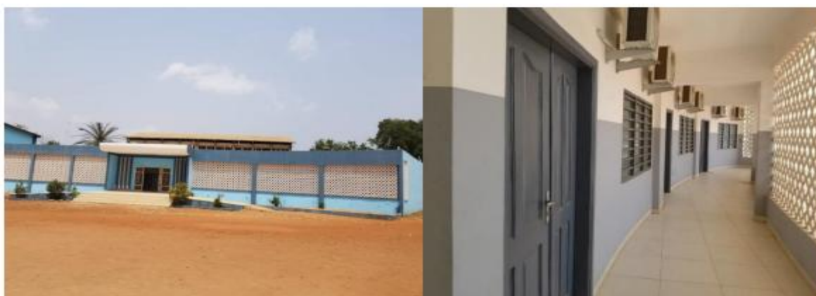
Photo 55 : Montrant construction du bâtiment de L'INE : Rez-de-chaussée des deux ailes.
