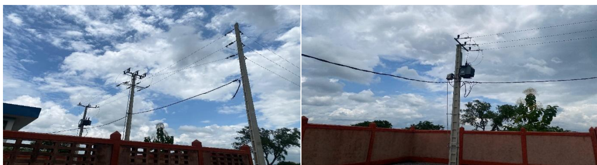
Photo 6 : Ligne électrique Moyenne Tension (MT) et Basse tension (BT) avec transformateur de 50 KVA et sélecteur aérien IACM pour moyenne tension (conforme)
