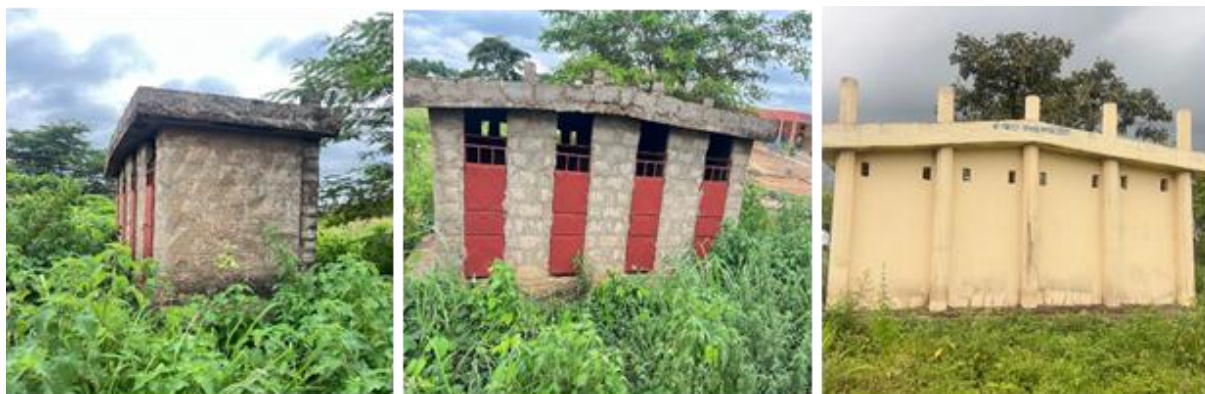
Photo : montrant construction des modules de latrines institutionnelles à quatre cabines à vidange arrière avec lave-mains
