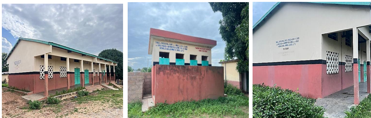
Photo 4 : Montrant construction de quatre (04) modules des (02) deux classes avec bureau et équipements plus latrine à l'EPP TEPABA ET EM ZOUNTORI dans la commune de Djougou, lot 2
