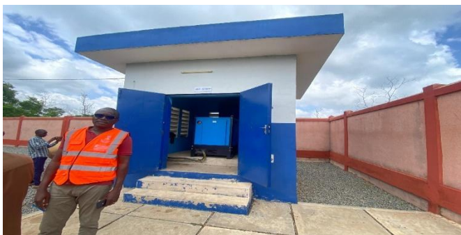
Photo 3 : Compteur SBEE de 30 A (conforme) Photo 4 : Bâtiment abri-groupe 3.40X3.40 et parafoudre (conforme)
