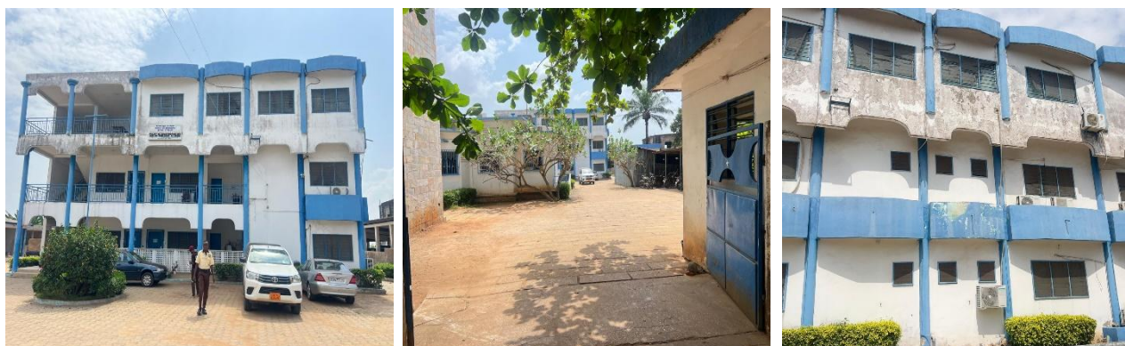
Photo 35 : montrant travaux de Réfection du siège de l'Unité de Gestion du Programme Japon VI
