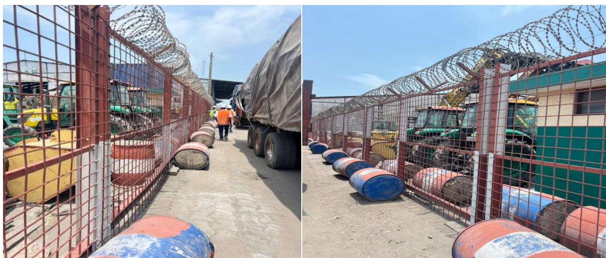
Photo 74 : Montrant les clôtures grillagées et les portails réhabilités sur le site.
