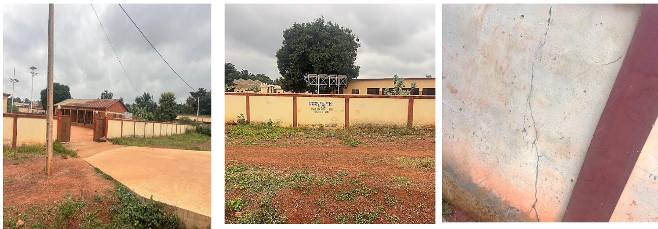
Photo 11 : Montrant la construction de 289ml de clôture du centre de MOUGNON dans la commune de DJIDJA. L'ouvrage existe et a été bien réalisé.
