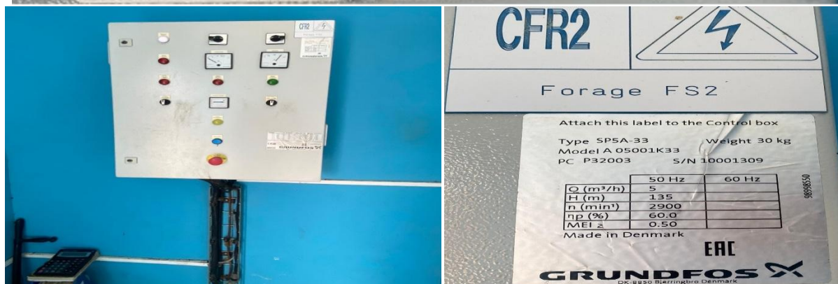
Photo 7 : Armoire de commande de puissance 3KW, de Hauteur Manométrique Totale HMT de 135m et de débit pompe immergée Q = 5m³ au lieu de 7m³ qui est prévu (non conforme)
