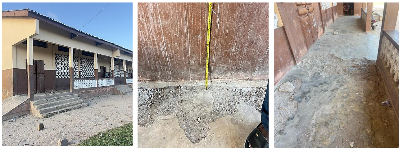
Photo : Montrant 02 modules de 03 salles de classes + bureau + magasin + latrines + clôture à l'EPP OKOUN-SEME
