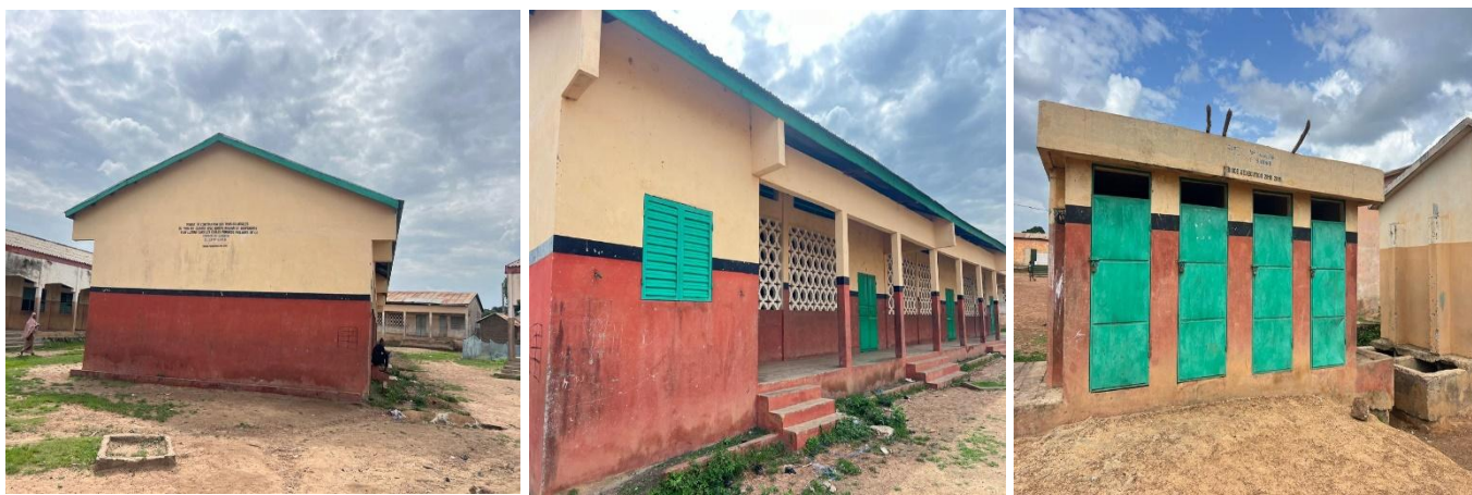
Photo 4 : Montrant trois modules de trois classes avec bureau magasin et équipement plus latrines dans l'EPP SABARRI et ANANIGA
