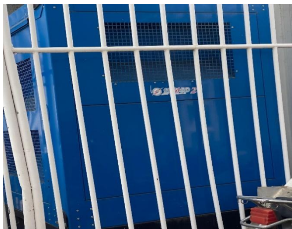
Photo 1 : Groupe électrogène GEMAP2 de 150 KVA (conforme).
