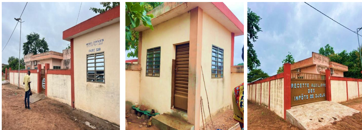
Photo 3 : Montrant la construction de la clôture avec guérite du bâtiment F4 de la commune de DJIDJA
