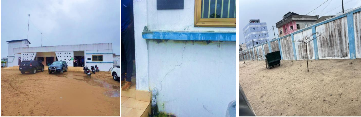
Photo 35 : montrant travaux de construction du siège du 1eme arrondissement de la ville de Cotonou
