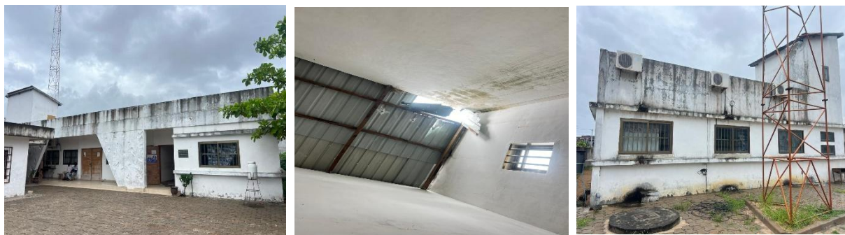
Photo 35 : montrant construction, reconstruction ou réfection de l'hôtel de ville de Cotonou
