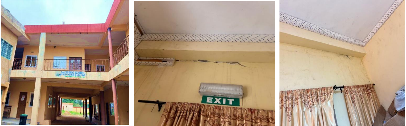
Photo 1 : Montrant les travaux d'extension du bloc administratif de type R+1 à la mairie de DJIDJA.
