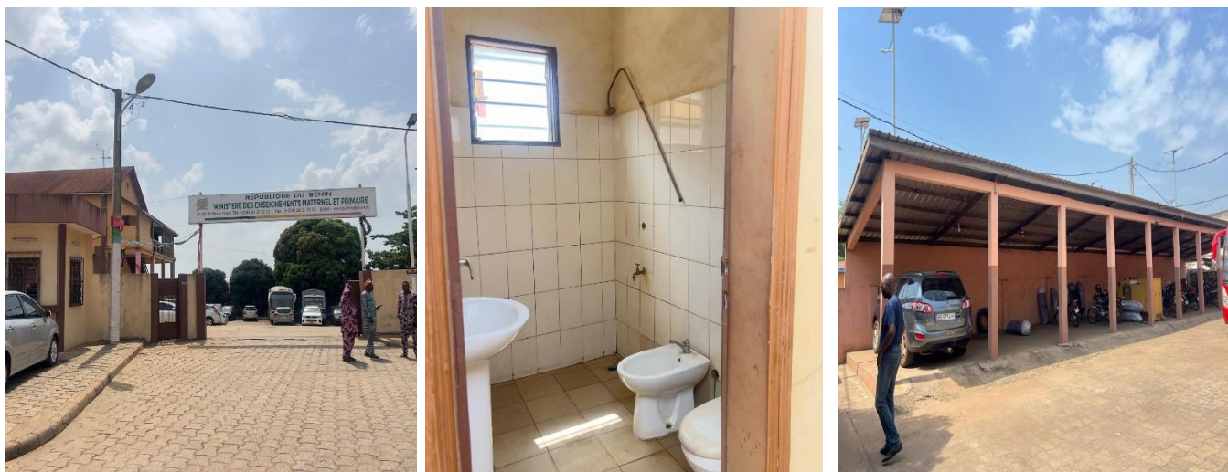
Photo 55 : Montrant travaux de réfection de bâtiment administratif
