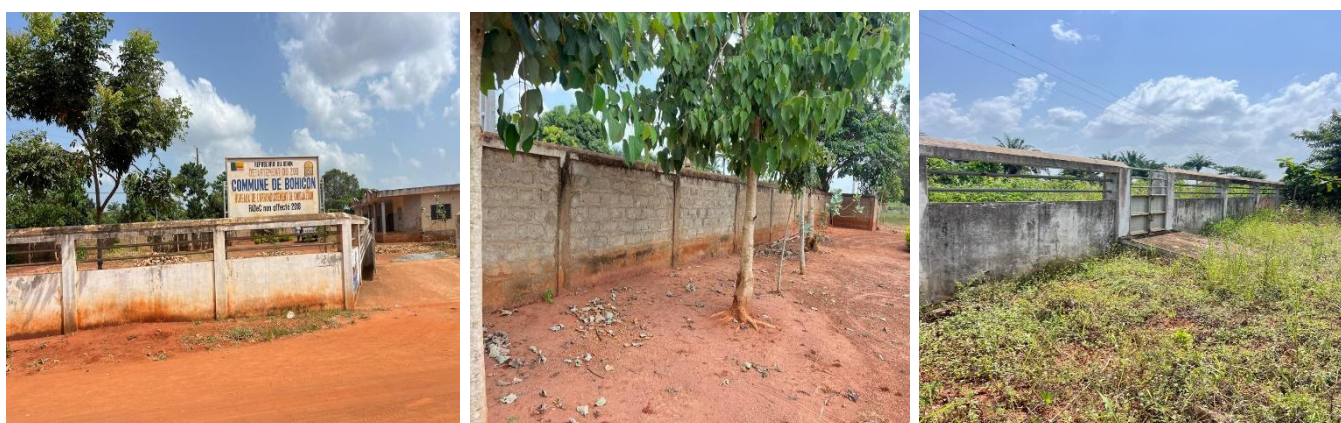
c) Photo 35 : Illustrant les travaux réalisés, notamment la façade principale badigeonnée et crépie, et les dimensions effectives des portions constatées sur le terrain.
