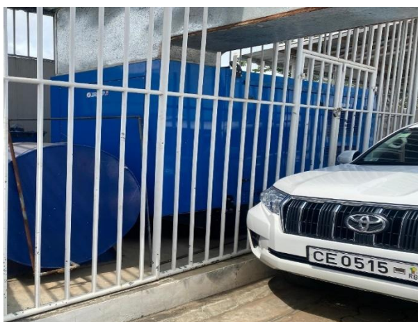
Photo 1 : Groupe électrogène GEMAP2 de 150 KVA (conforme).
